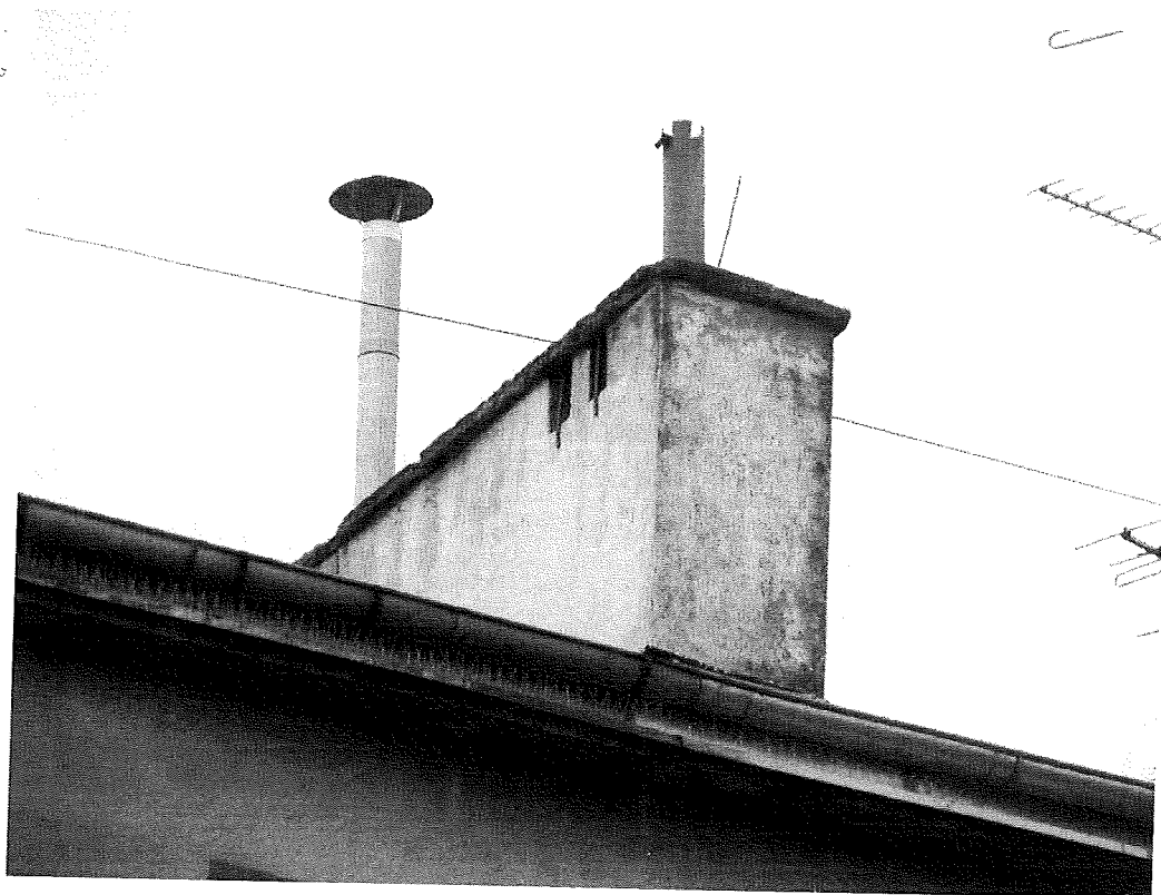
Fot.2. Wloty do kominów są zabezpieczone (aut. Szymon Wójcik).
